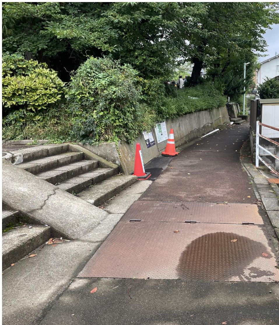
春日神社付近の四ツ谷用水(暗渠区間)
